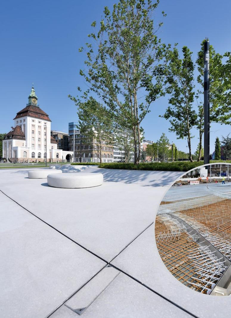
Denn die in unterschiedlichen Radien angeordneten Rinnenstränge, die für eine schnelle und sichere Entwässerung des Platzes sorgen, folgen den Formen der geschwungenen Pflanzinseln. Wie ein Netz spannen sie sich über den reflektierenden Beton.
