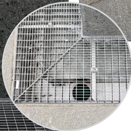
Die bis zu 3 m langen Rinnenelemente werden über montagefertige, angeschweißte Flanschverbindungen mit EPDM-Dichtung und Schrauben miteinander verbunden und bilden so ein dichtes Rinnensystem. Das am Platz der Alten Synagoge gewählte Rinnensystem der Belastungsklasse A 15 nach DIN EN 1433 ist für leichten Fahrverkehr geeignet. Die Abdeckung erfüllt die Rutschhemmung nach BGR 181 gemäß DIN 51130 bzw. Rutschwiderstandsklasse der Abdeckungen nach DIN EN 1341 für Außenbereiche.
