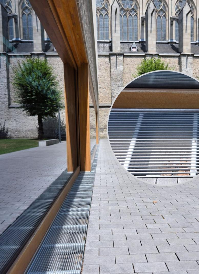
Betonwerksteinelemente integriert. Voraussetzung für die großen Sauberlaufzonen war auch die von Inotec in jedem Längsstab des Rostes eingearbeitete Rutschhemmung, die eine sichere Nutzung beim Begehen des Rostes gewährleistet.
